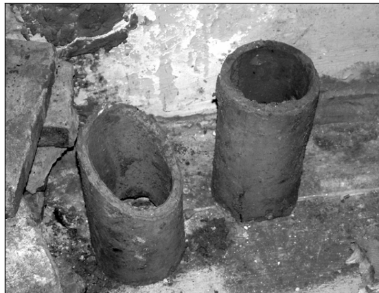
Рис. 11. Керамічні труби, імовірно, дренажної системи, влаштованої по внутрішньому периметру зовнішніх стін. Фотографія 2005 р.
