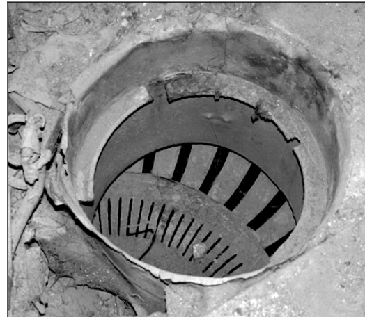
Рис. 10. Вид з даху розетки з вентиляційними отворами. Фотографія 2005 р.
