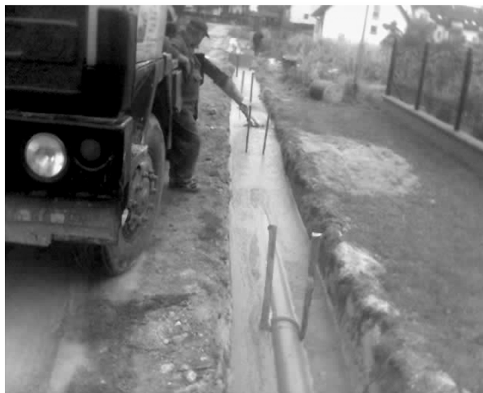
Рис. 5. Прокладання каналізаційних мереж в пінобетоні на глибині 40 см від поверхні (м. Замость, Польща, 2005 р.)
