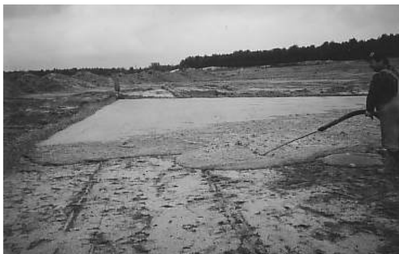
Рис. 3. Виконання основи з пінобетону під паркінг в Нідерландах
