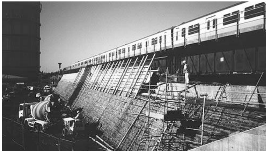
Рис. 6. Підсилення пінобетоном конструкцій масиву насипу залізничного моста в процесі його експлуатації
