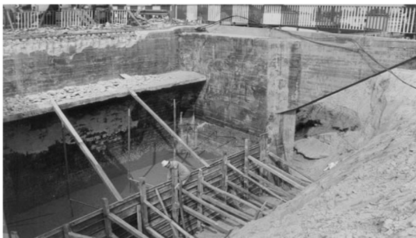
Рис. 4. Заповнення підпори віадука пінобетоном в м. Ольштин, Польща
