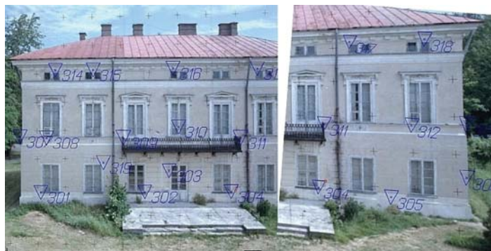
Rys. 4 Schemat rozmieszczenia fotopunktów na elewacji budynku
