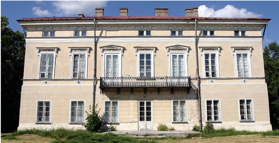
Rys. 2 Elewacja ogrodowa Pałacu Lubomirskich
