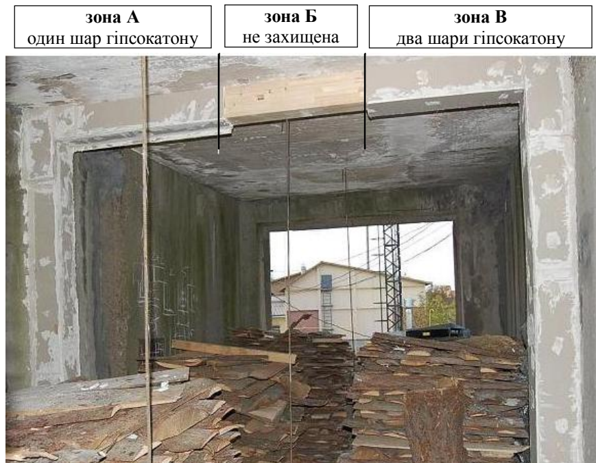
Рис. 1. Конструкція рами, підготовлена до випробувань в приміщенні з встановленим пожежним навантаженням
