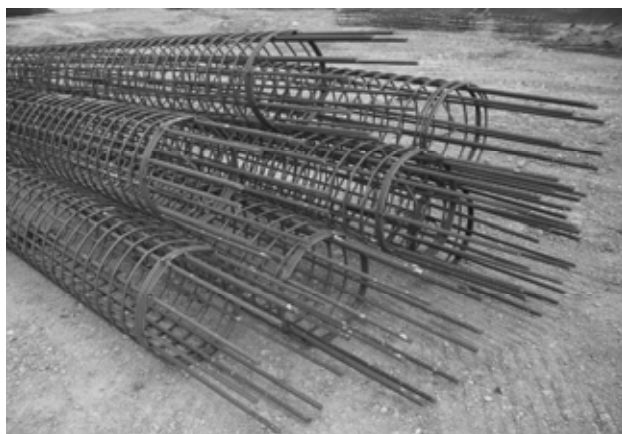
Рис. 2. Зовнішній вигляд просторових арматурних каркасів
