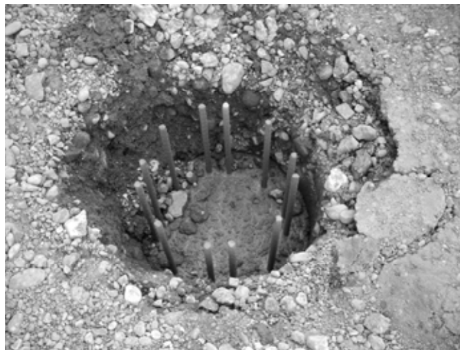
Рис. 3. Зовнішній вигляд свердловини, щойно заповненої бетоном
