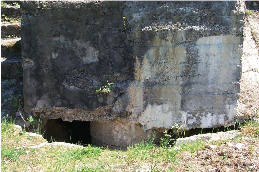
Рис.3. Результати руйнування підпірної стінки дросельного затвору.
