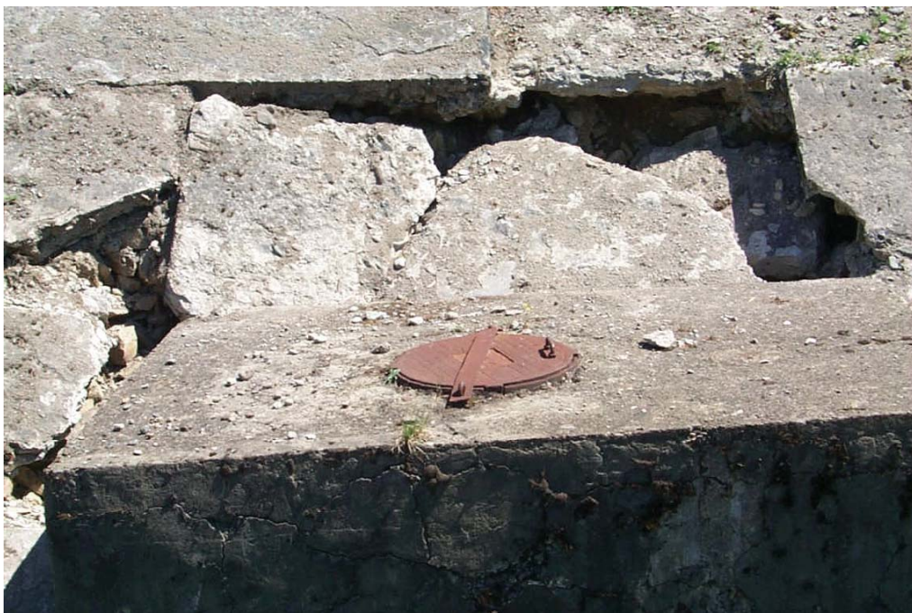
Рис.4. Утворені пустоти в тілі підпірної стінки.
