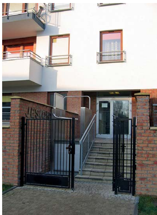
Рис. 4.17. Механізм вертикального підйому візочків з неповносправними на рівень майданчика перед входними дверима в будинок (Варшава)
