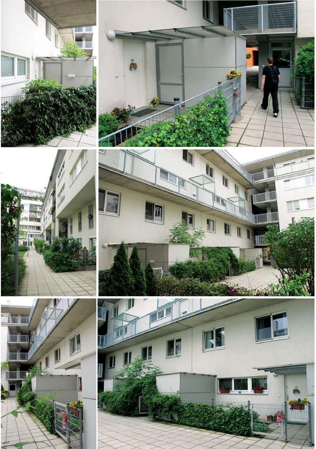
Рис. 6.104. Палісади з огорожею і великими господарськими комірками при індивідуальних входах у квартиру в галерейному будинку
